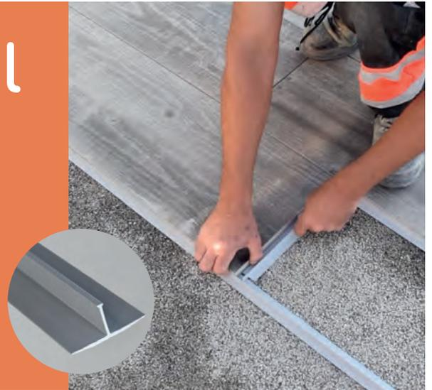
Das **steinfix® Fugenprofil** füllt die Fugen bei lose verlegten Keramik- oder Natursteinplatten. Es verhindert Unkrautwuchs und garantiert ein dezentes Fugenbild. Des Weiteren sorgt es dafür, dass Wasser versickert ( Kapillarkraft saugt Wasser ab) und bildet eine stabile, durchgängige Auflage der Platten. **Hinweis zu den Querprofilen:** 295 mm für 30-cm-Platten, 395 mm für 40-cm-Platten, 495 für 50-cm-Platten, usw.
